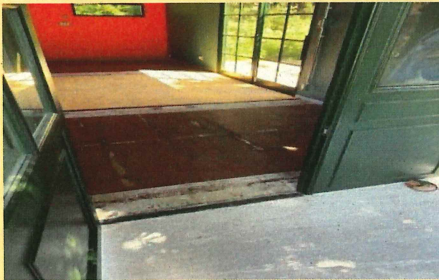
体験プログラムの会場整備(アプローチスロープ、出入り口・店舗内の段差解消)
